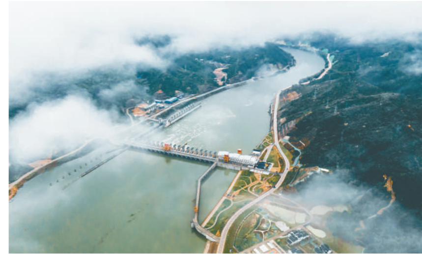
图3:广东韩江高峡水利枢纽工程(公司供图)
