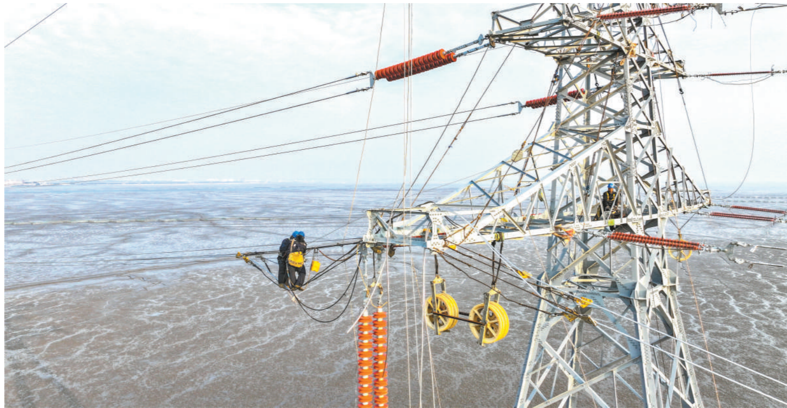
1月26日,福建福清,国内跨海距离最长的架空输电线路全线贯通。该线路总长约30公里,新建铁塔79座,共有30座铁塔位于海中。中新社发 谢贵明/摄
