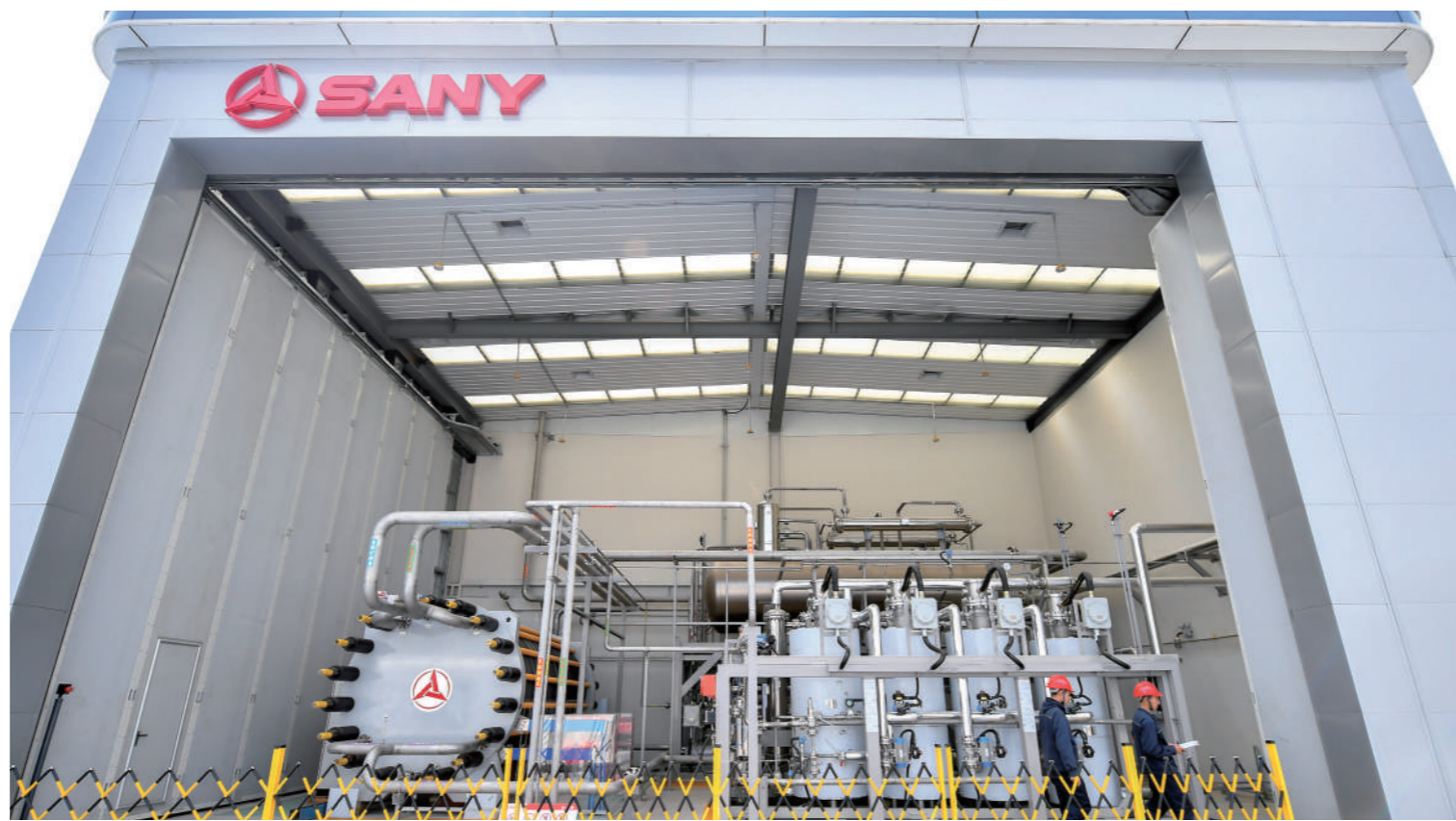
近日，位于湖南长沙经开区的三一绿电制氢加氢一体站建设完成，这是国内最大的绿电制氢加氢一体站。该站点每日的制氢加氢量不少于2吨，增压储存区总储氢量超过1000公斤，每天可服务氢能车辆数量超过百台。新华社/图文
