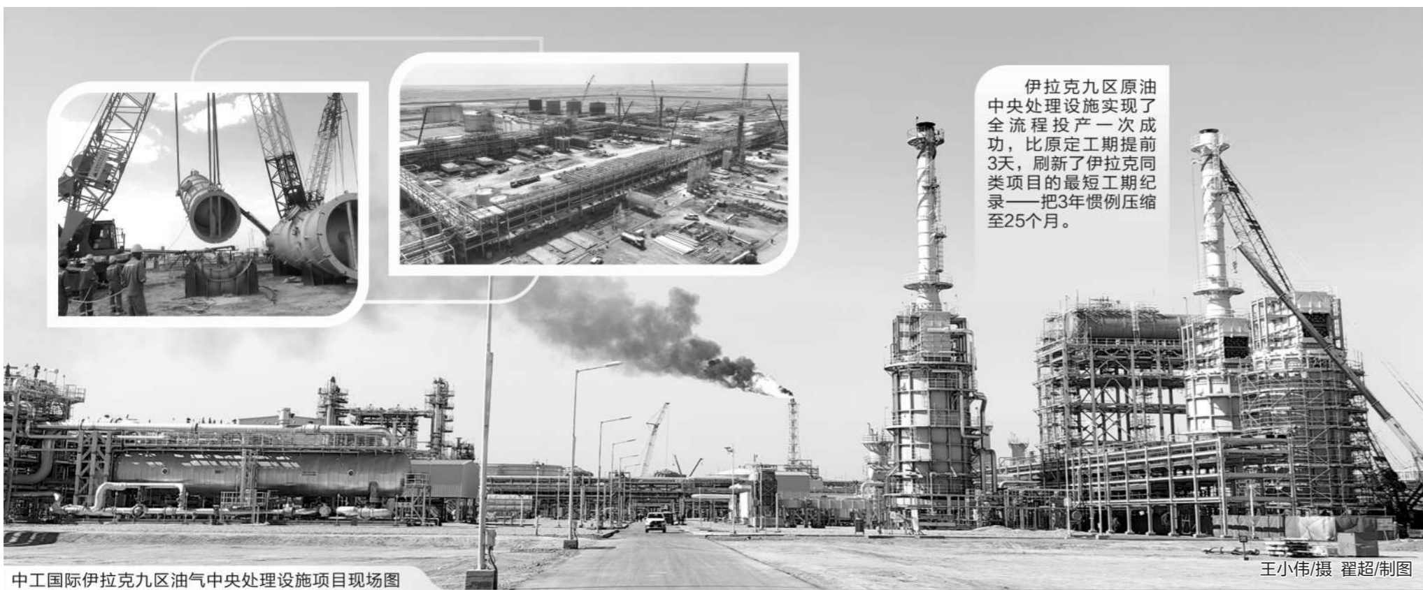
中工国际伊拉克九区油气中央处理设施项目现场图
