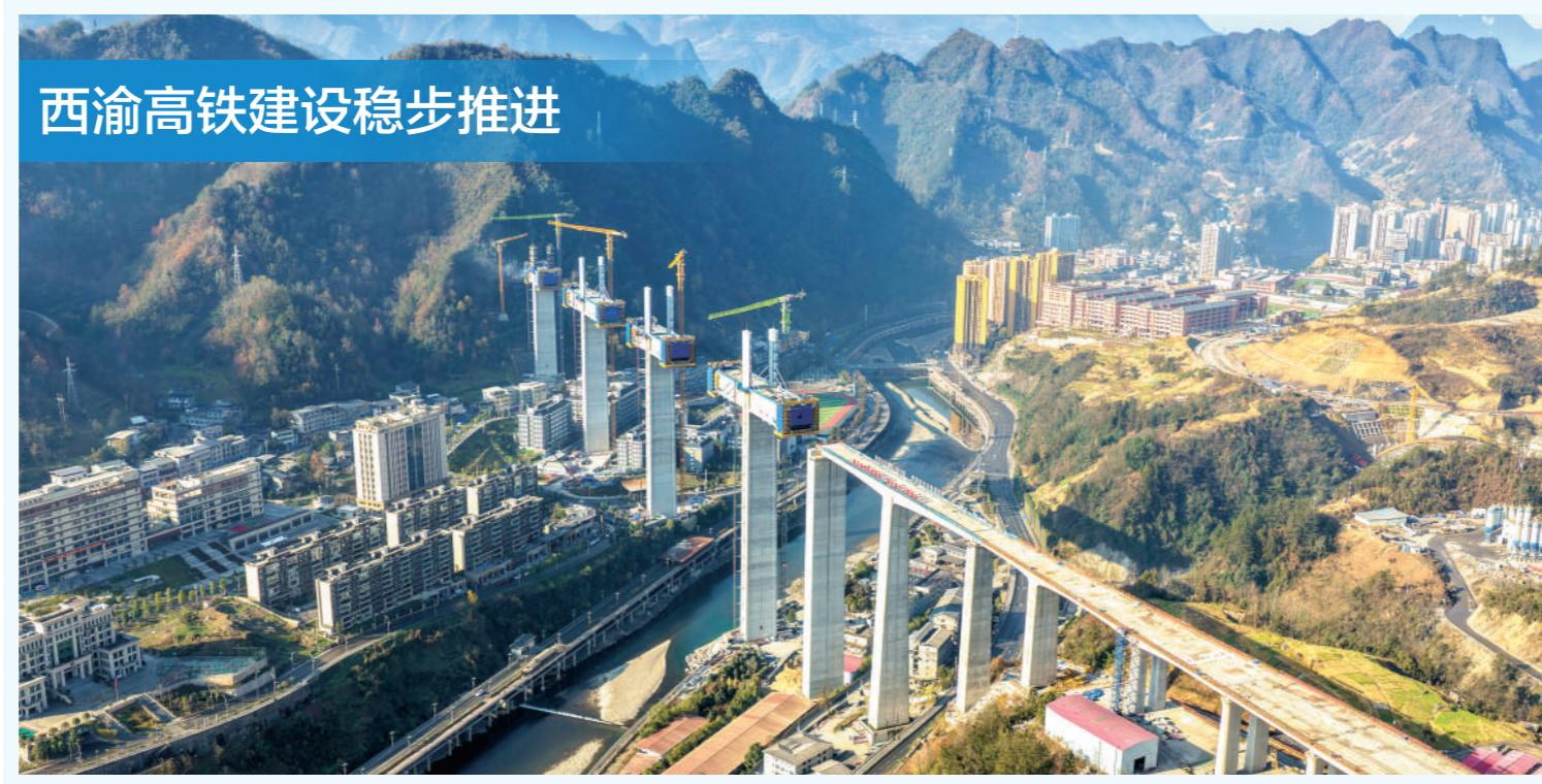
12月7日,由中铁十二局承建的西渝高铁城口任河特大桥塔柱施工任务全部完成,全桥施工进度完成近七成,为西渝高铁全线按期贯通奠定了基础。西渝高铁是我国“八纵八横”高铁网北京至昆明的京昆通道和包头、银川至海口的包(银)海通道的重要组成部分,线路全长739公里,设计时速350公里。
