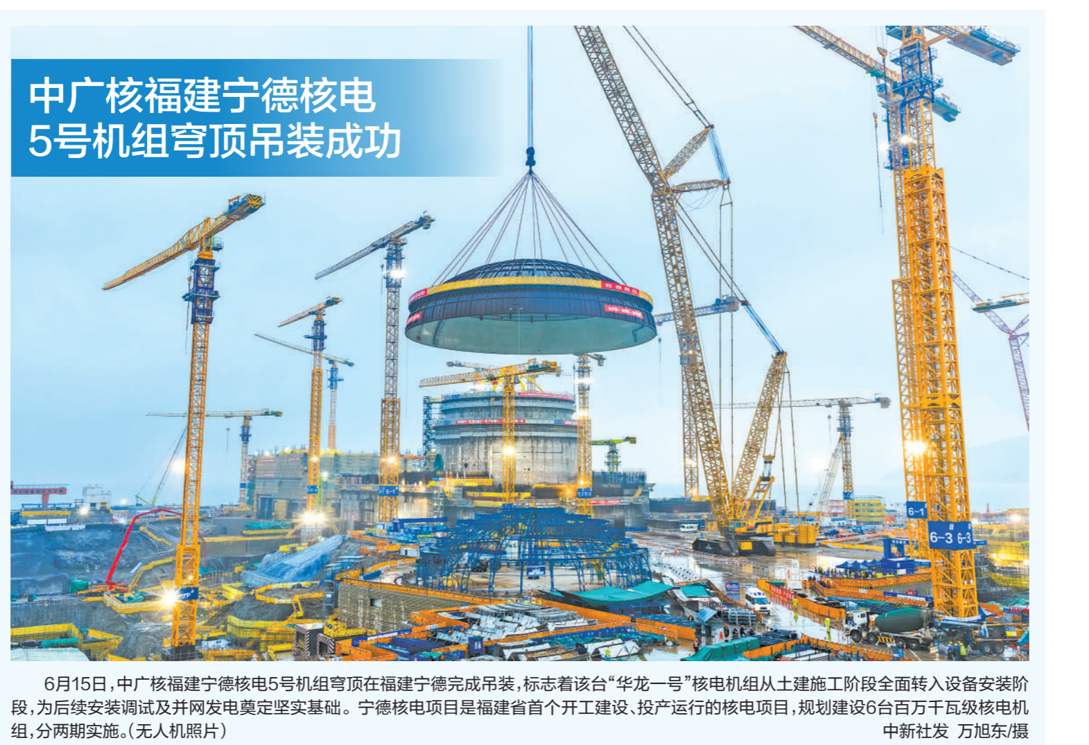
6月15日，中广核福建宁德核电5号机组穹顶在福建宁德完成吊装，标志着该台“华龙一号”核电机组从土建施工阶段全面转入设备安装阶段，为后续安装调试及并网发电奠定坚实基础。宁德核电项目是福建省首个开工建设、投产运行的核电项目，规划建设6台百万千瓦级核电机组，分两期实施。(无人机照片) 中新社发 万旭东/摄
