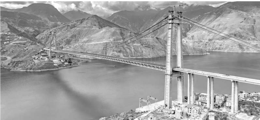
图为蜀道集团投建的宜攀高速卡哈洛金沙江特大桥。 唐强/供图
