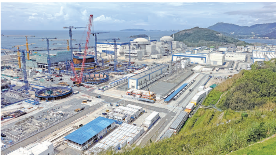
中广核广东太平岭核电基地建设现场一片繁忙。
