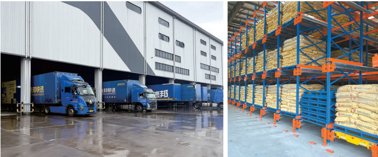
左图为入驻杭州传化公路港的德邦快递,右图为今年8月刚刚完成智能仓库改造的杭州传化公路港。 李小平/摄
