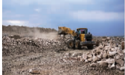
文瀛湖驳岸现场施工
