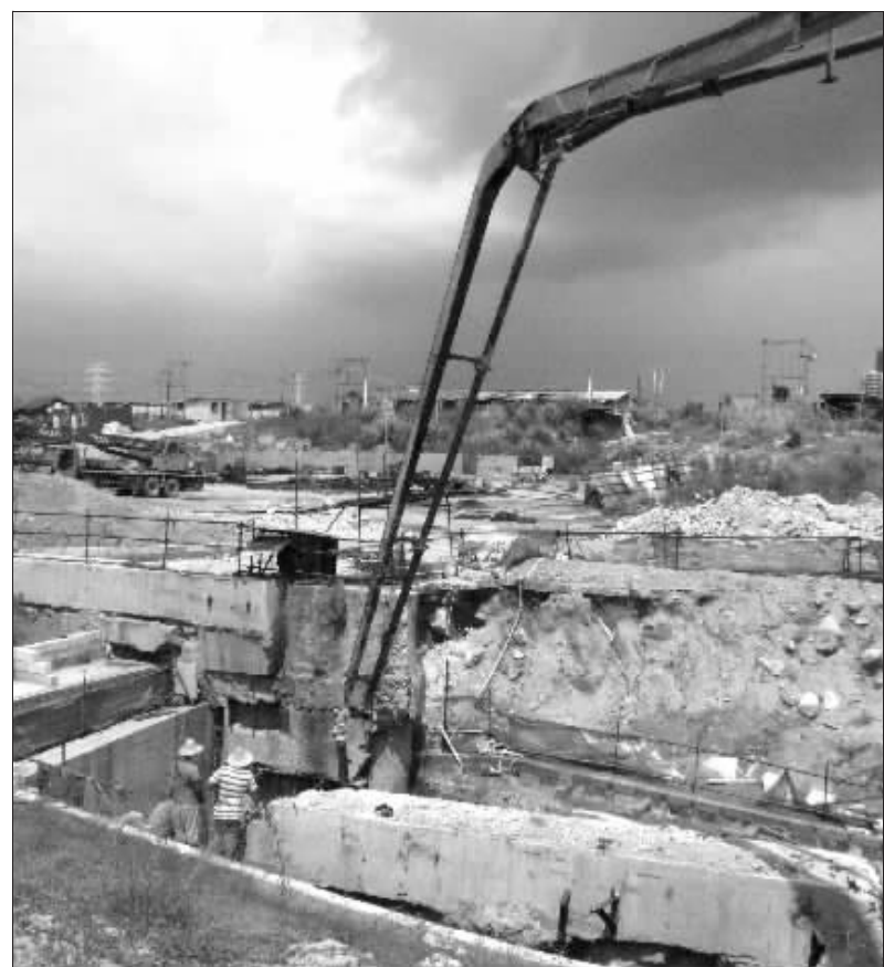
图为深圳前海地铁施工现场 IC/供图
