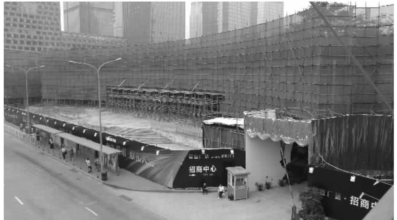
正在装修的晶岛项目
