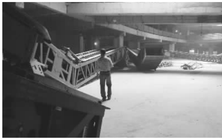
十多部电动扶梯因内部结构变更被拆卸
