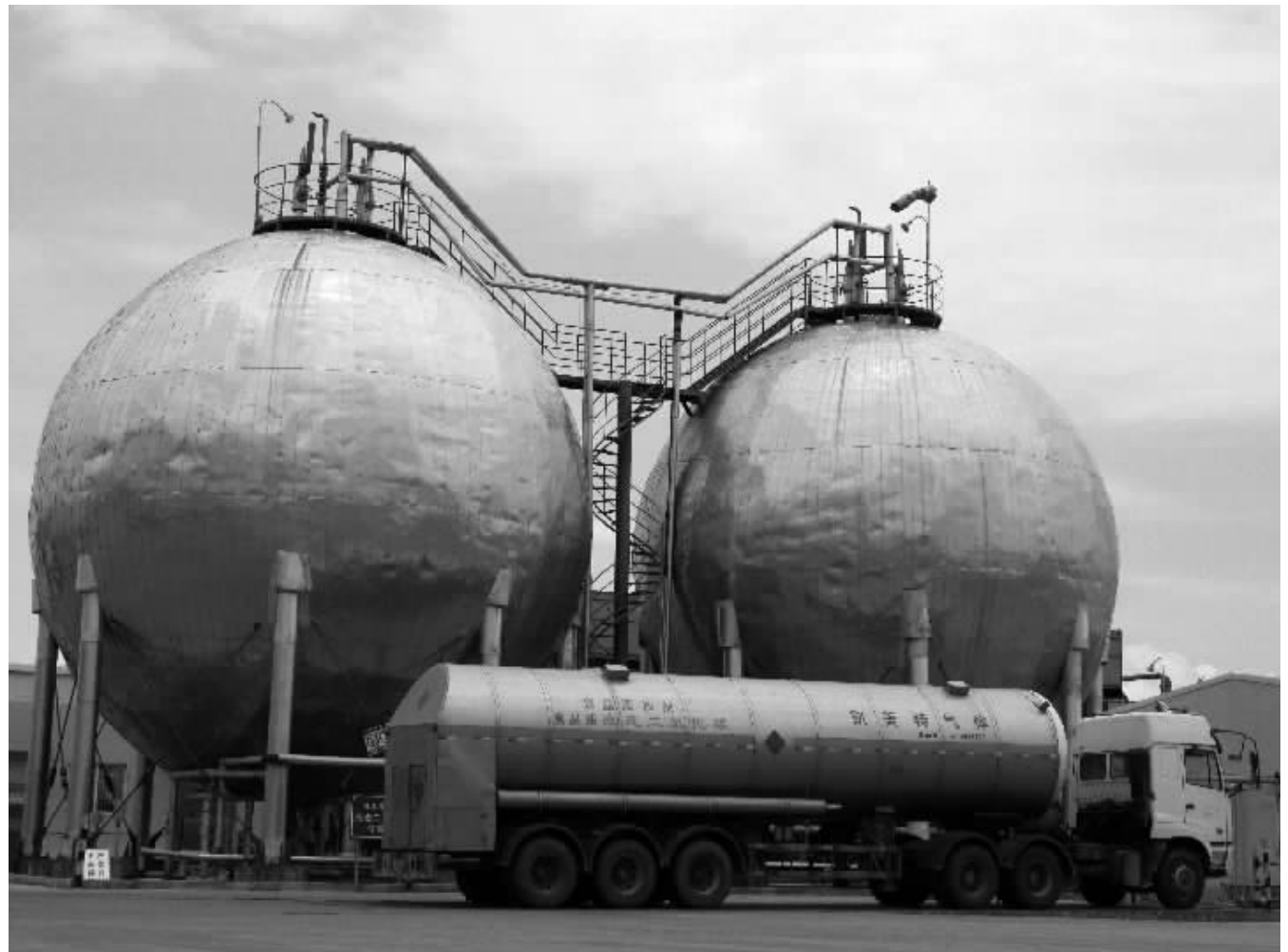
两个直径约15米的银白色大圆球,缓缓吃下经过压缩、净化的二氧化碳
