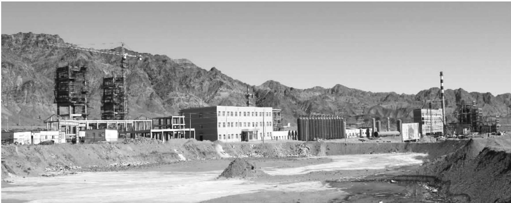
18万吨合成氨在建项目
