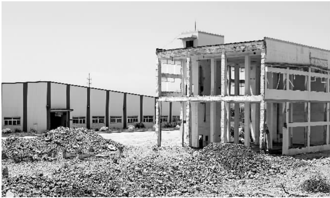
已拆除的大元股份大连分公司6号租赁厂房(2011年7月)
