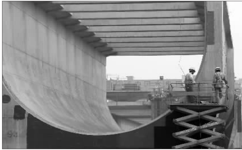
图为河南正在建设中的南水北调中线沙河渡槽工程 IC/供图
