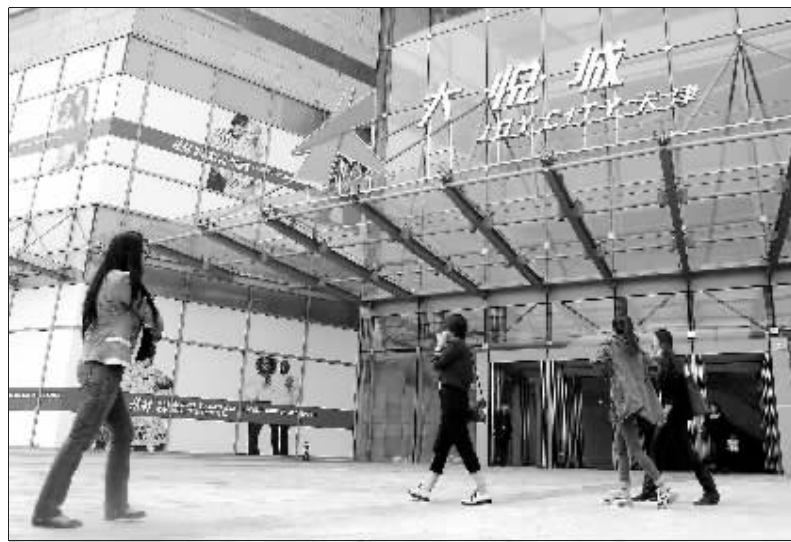
图为天津中粮大悦城城市综合体项目
