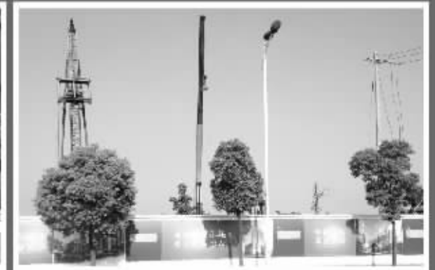
南太湖正在建设的安置房 杨丽花/摄 彭春霞/制图
