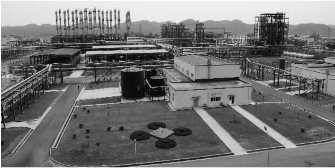
乐电天威生产厂区
