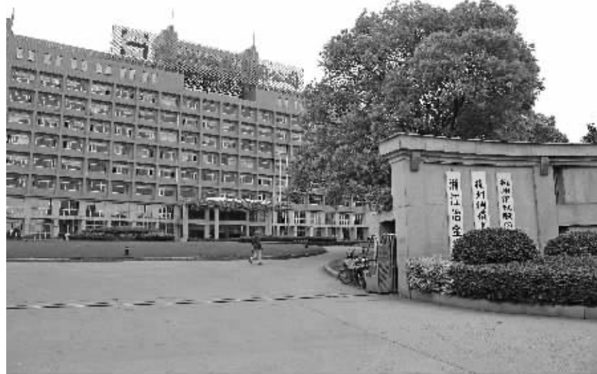
图为杭钢股份厂区
