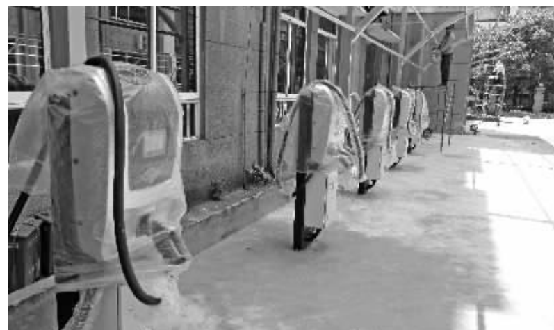
杭州新能源汽车展销中心外场,正在安装一批充电桩 徐然/摄
