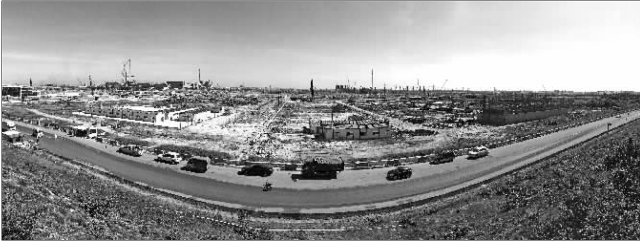
宝钢湛江基地正在紧张施工
