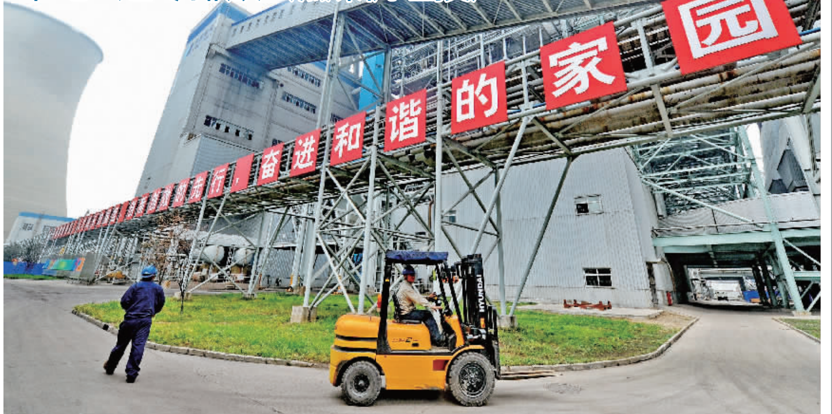
日前，河北华电石家庄裕华热电公司1号机组通过河北省环境监测中心站验收并投产，达到“近零排放”要求，成为华电集团在全国范围内率先实现“近零排放”的燃煤机组。 新华社/图文
