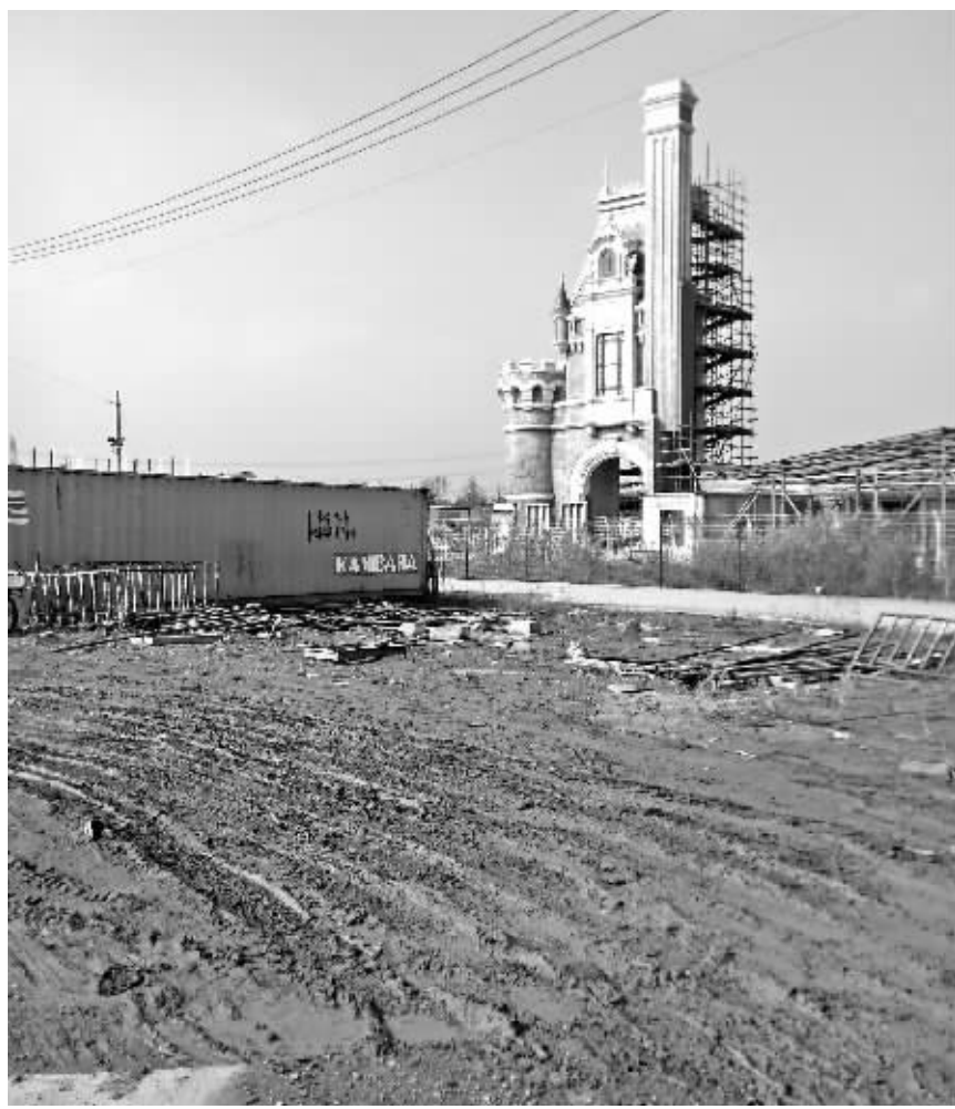
正在施工当中的上海迪士尼乐园。
