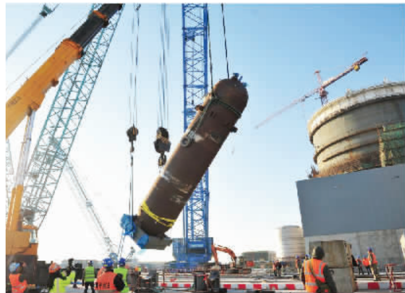
国内一家核电项目建设现场
