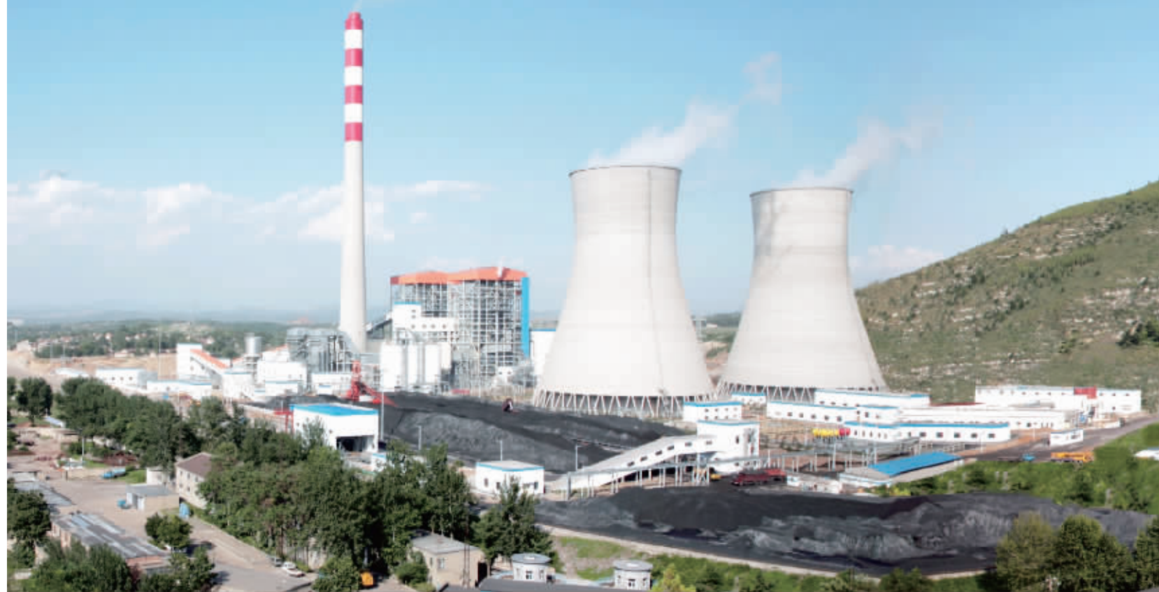
据国家能源局7月4日消息,为加快能源技术创新,挖掘燃煤机组调峰潜力,提升我国火电运行灵活性,全面提高系统调峰和新能源消纳能力,确定丹东电厂等16个项目为提升火电灵活性改造试点项目。这16个试点项目的地域分布情况为:辽宁7个,吉林2个,黑龙江、甘肃、广西、河北各1个,内蒙古3个。 中国财经图库/供图
