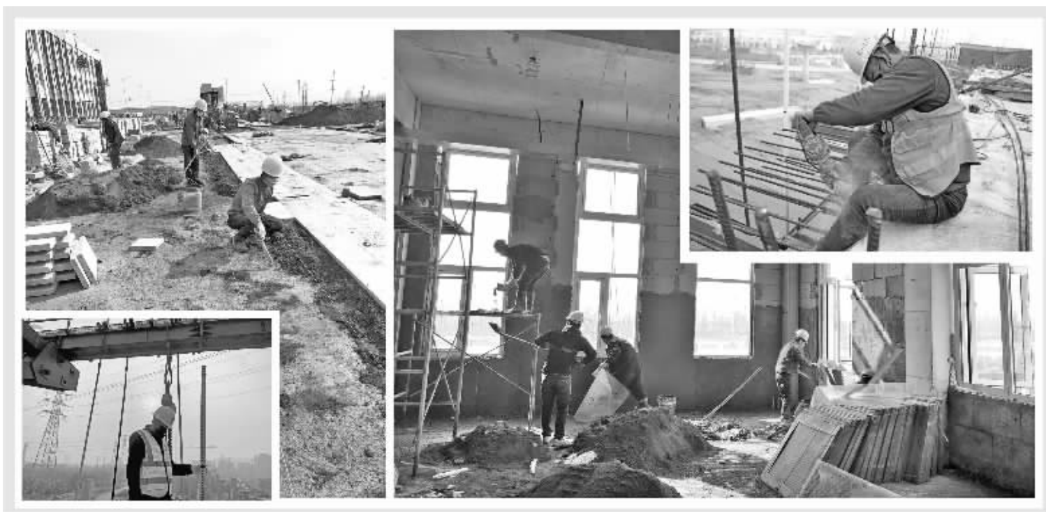
河南部分开工项目施工现场
