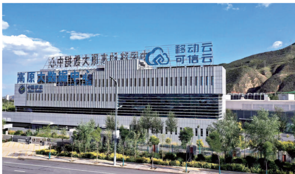
中国移动高原大数据中心。刘灿邦摄
