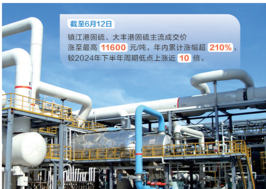
图为煤制气硫磺回收装置。 时报财经图库/供图
