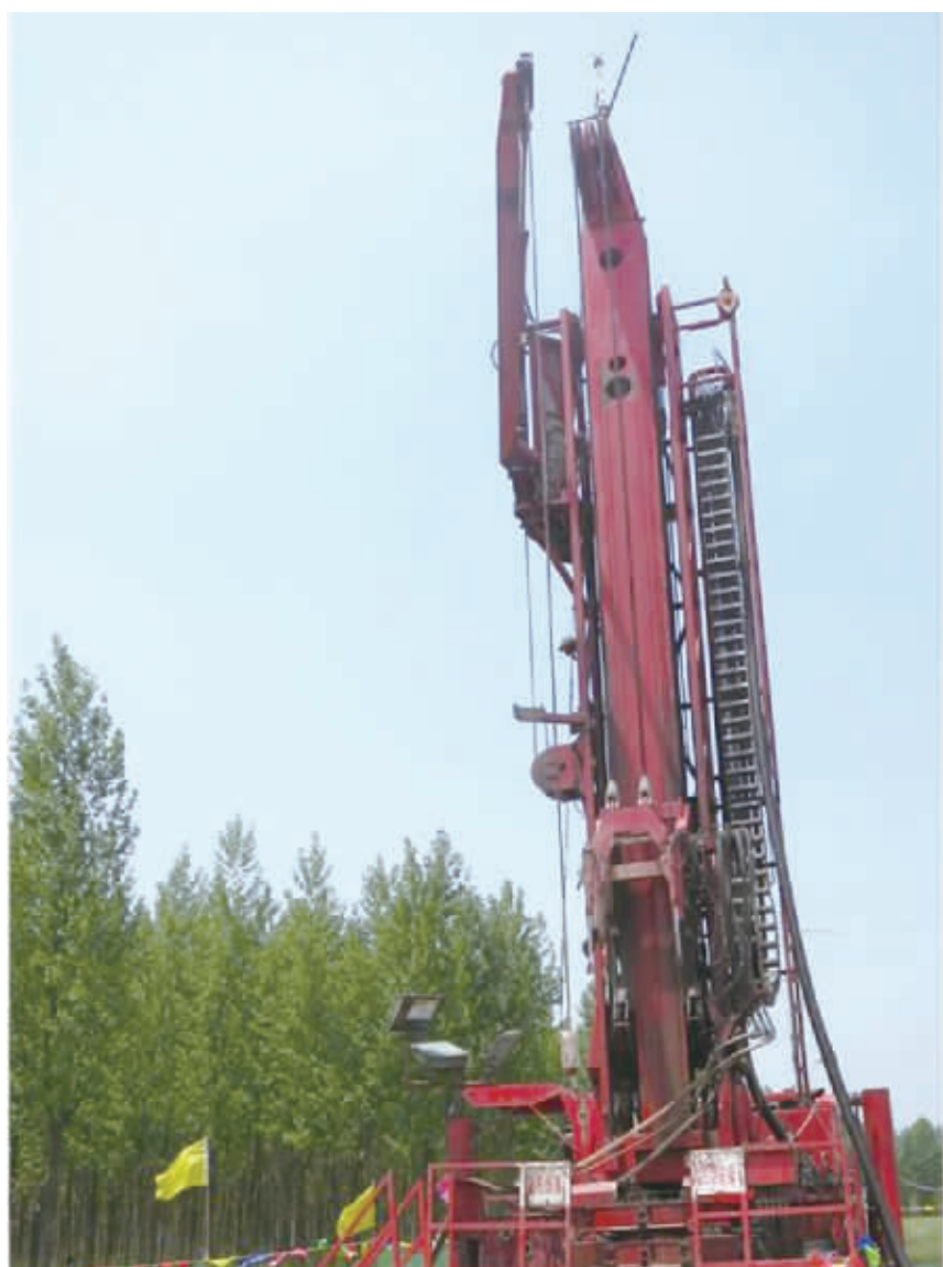
在宿南区块施工的钻深超过千米的钻机
